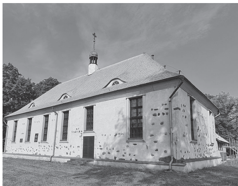
5. Wymiana pokrycia dachu cerkwi pw. św. Jerzego w Bytowie, 2022 r.
