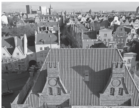
6. Zespół Dworu Miejskiego – remont dachu Baszty Schultza w Gdańsku, 2022 r.
