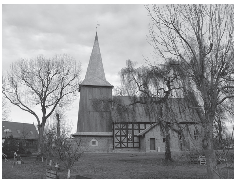
17. Rekonstrukcja hełmu wieży kościoła pw. św. Mikołaja w Żelichowie, 2024 r.
