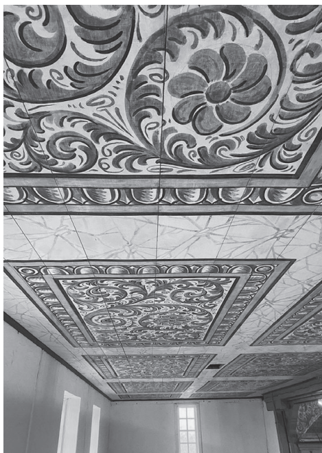
1. Neobarokowy polichromowany strop z kościoła pw. św. Wawrzyńca Męczennika w Brzeziu po konserwacji i restauracji. Północna nawa boczna, 2024 r.
