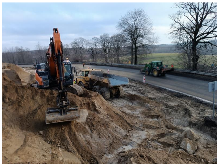
Fot. 14. Prace ziemne przy „Rozbudowie drogi wojewódzkiej nr 221 na odcinku od Jankowa do Obwodnicy Kościerzyny – Odcinek C – odcinek od m. Przywidz do m. Nowa Karczma” dofinansowanej w ramach FEP 2021-2027
