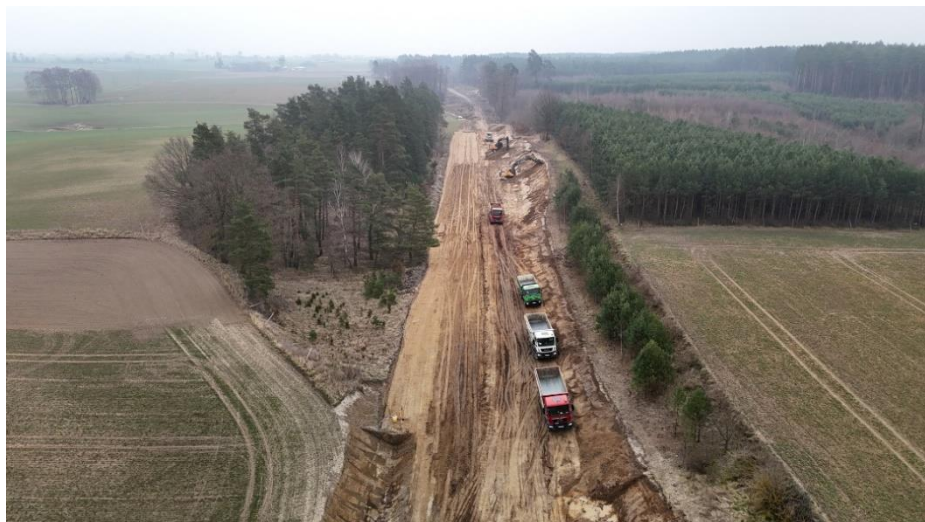
Fot. 16. Prace budowlane na obwodnicy Skórcza: „Budowie nowego przebiegu drogi wojewódzkiej nr 231 na odcinku od Skórcza do węzła autostrady A1 Kopytkowo. Etap I, Skórcz – Mirotki”
