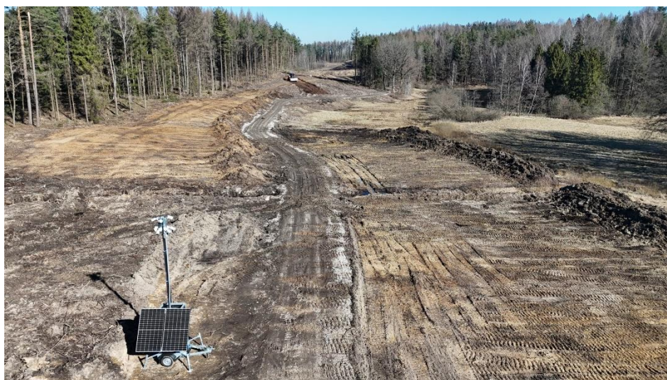
Fot. 15. Prace budowlane na budowie II etapu obwodnicy Kartuz
