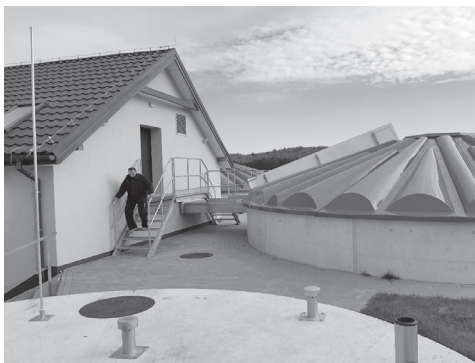
Budowa oczyszczalni ścieków w Trąbkach Wielkich
