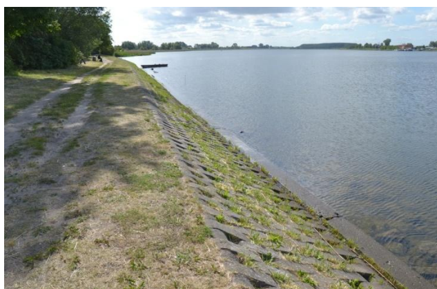
Fot.5 Nabrzeże Martwej Wisły po wschodniej stronie mostu pontonowego
