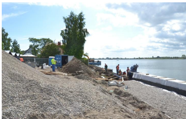
Fot. 3 i Fot.4 Budowa oczepu na terenie lokalizacji, widok w kierunku mostu w Sobieszewie
