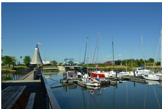
Fot.5 Kładka i pomost pływający, z tyłu: bramownica i slip
