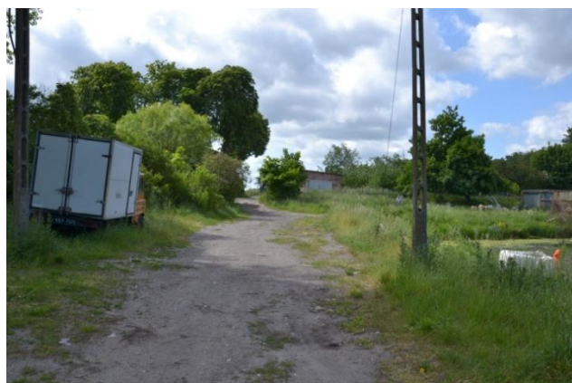
Fot.3 Obecny stan drogi na terenie portu rybackiego
