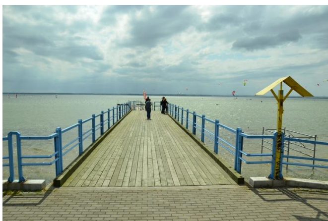
Fot.3 Przyczółek pomostu
