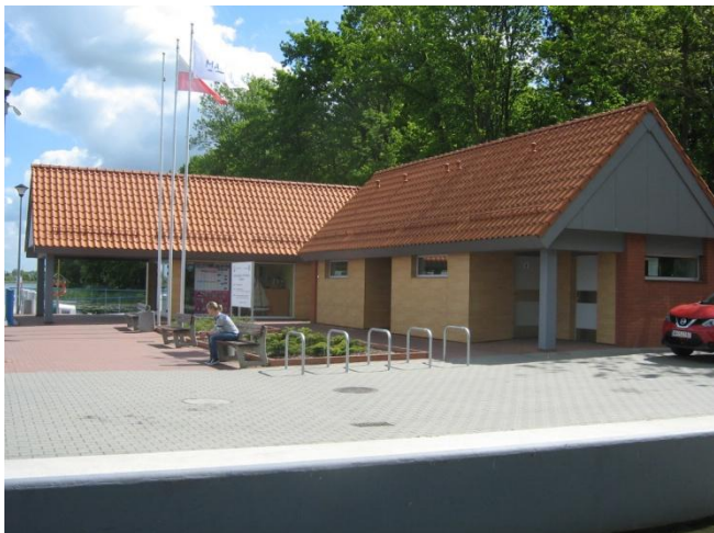
Fot.1 Widok na budynek bosmanatu i sanitariaty
