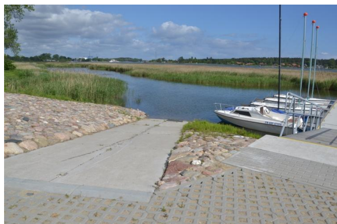
Fot.4 Betonowy slip do wodowania jednostek
