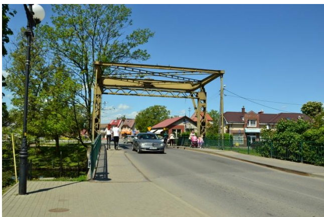
Fot.1 Asfaltowa nawierzchnia mostu do zdjęcia
