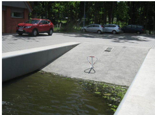
Fot.2 Widok na slip i parking
