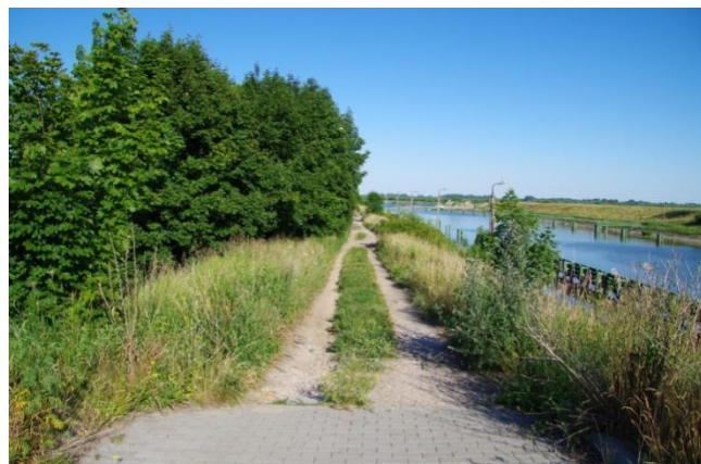
Fot.2 Widok na wał pomiędzy nieczynną śluzą Północną a czynną śluzą Południową
