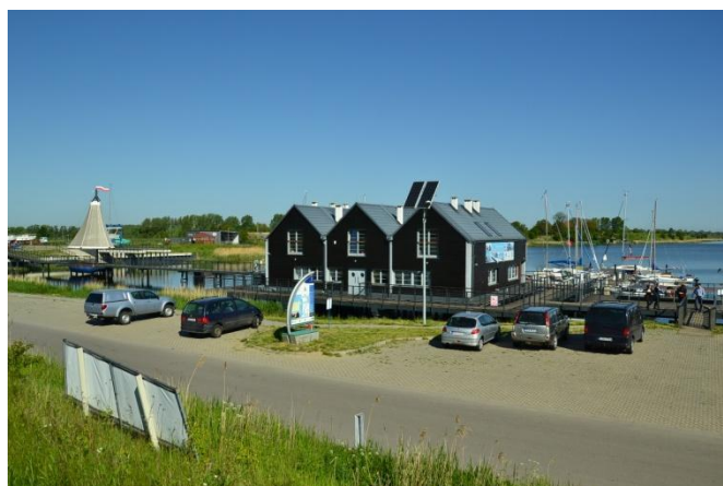
Fot.6 Budynek sanitariatów i bosmanat
