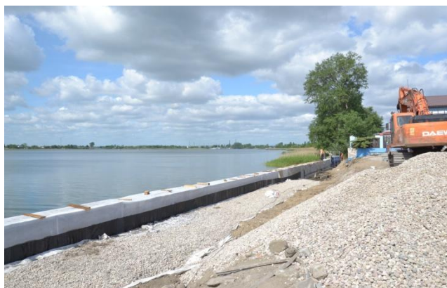
Fot. 1 i Fot.2 Budowa oczepu na terenie lokalizacji, widok w kierunku Górek Zachodnich
