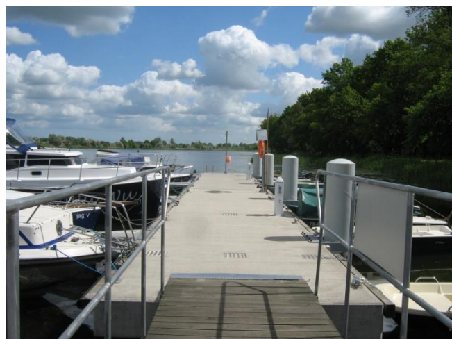
Fot.4 Widok na pomost pływający i rzekę Nogat, strona północno-wschodnia – na końcu pomostu znajduje się lokalizacja projektowanego nowego pomostu
