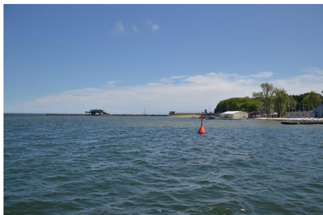
Fot.3 Widok z pływającego falochronu zachodniego na Basen Jachtowy i molo
