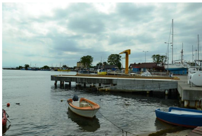
Fot.4 Widok na zachodnią część portu; infrastruktura żeglarska: dźwig, slip
