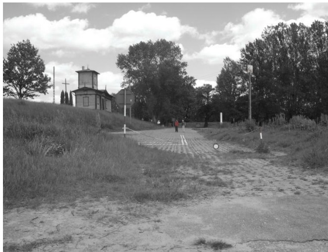
Fot.2 Widok na drogę dojazdową
