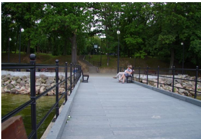
Fot.3 Widok na przyczółek, w stronę zachodnią
