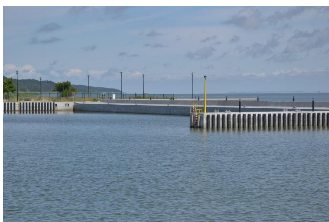
Fot.5 Miejsce mocowania pomostów
