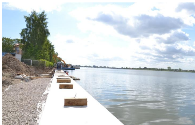
Fot. 3 i Fot.4 Budowa oczepu na terenie lokalizacji, widok w kierunku mostu w Sobieszewie
