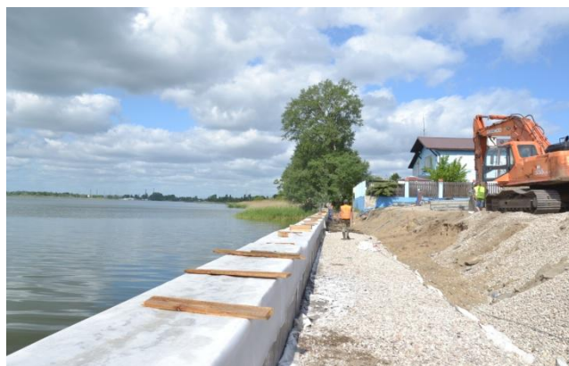
Fot. 1 i Fot.2 Budowa oczepu na terenie lokalizacji, widok w kierunku Górek Zachodnich
