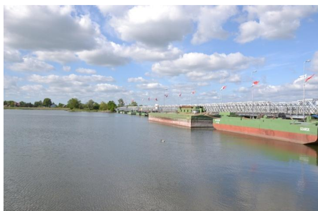
Fot.6 Widok na most pontonowy, w oddali lewy brzeg Martwej Wisły
