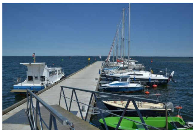
Fot.3 Pływający falochron zachodni
