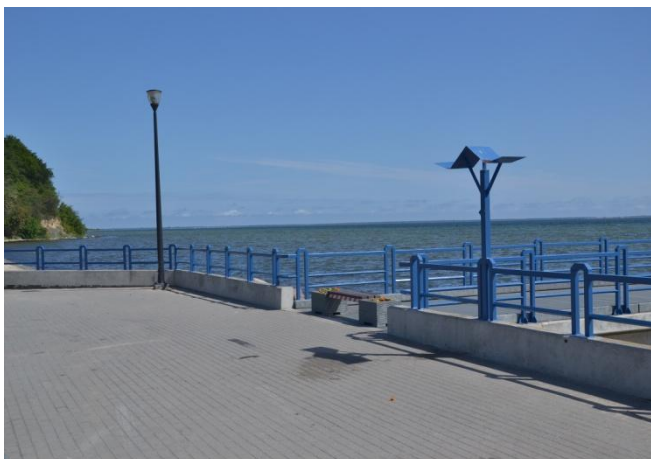
Fot.3 Widok na stały przyczółek pomostu, w stronę północną
