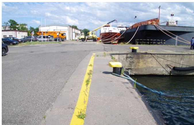
Fot.3 Widok na Nabrzeże Kutrowe, po prawej Pirs Nr 1, strona wschodnia
