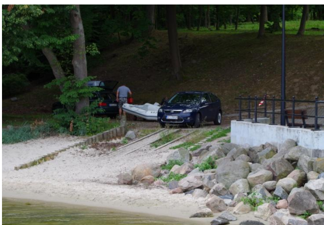
Fot.5 Widok na rampę do wodowania, od strony pomostu
