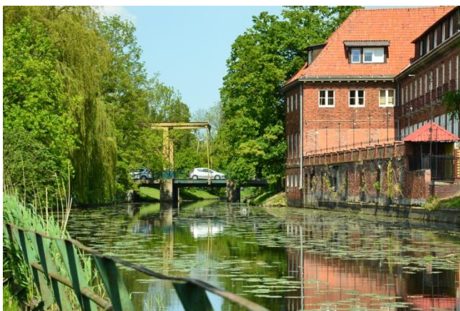
Fot.3 Widok od strony południowej
