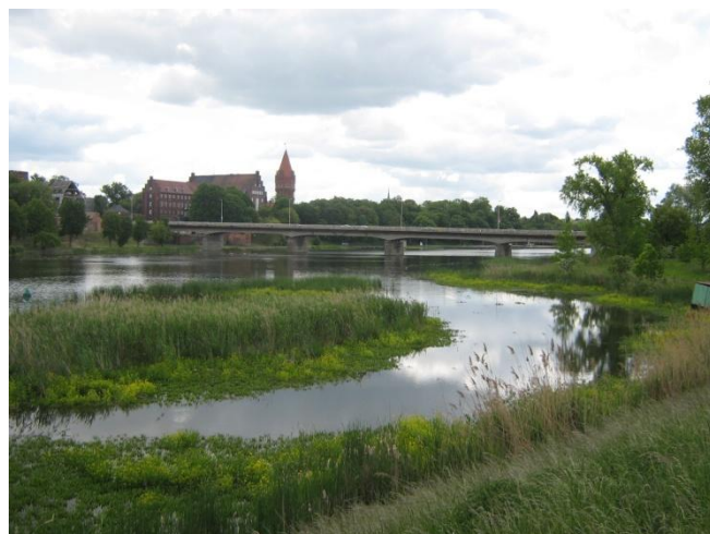
Fot.4 Widok na teren inwestycji, strona południowo-wschodnia
