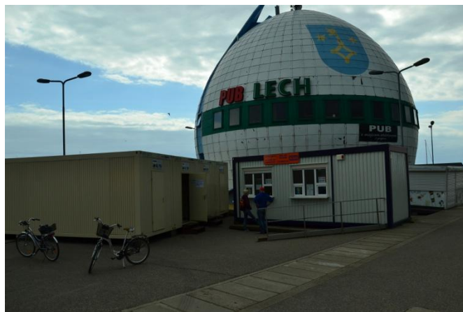
Fot.6 Widok na teren inwestycji i budynek rekreacyjny
