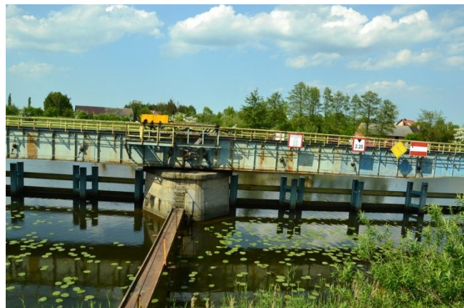
Fot. 2 Dojście dla obsługi mostu
