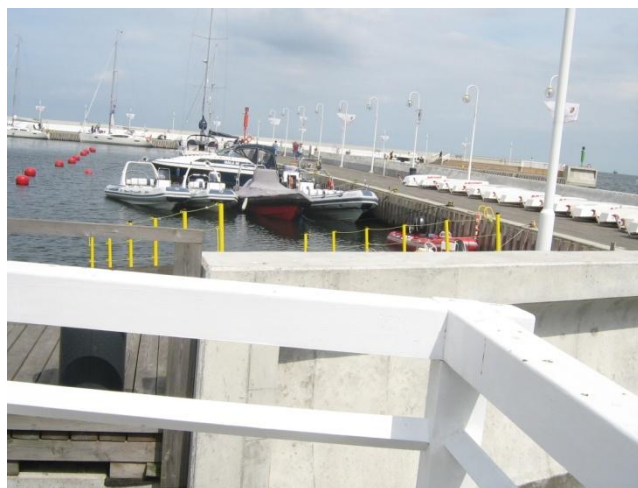
Fot.2 Widok na istniejącą marinę
