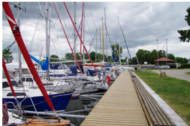
Fot. 2 Pomost cumowniczy wyposażony w Y-bomy
