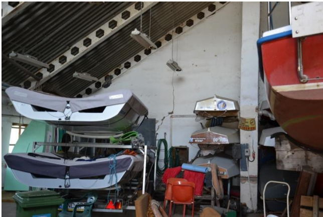
Fot.3 Wnętrze hangaru
