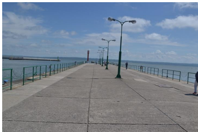
Fot.2 Stan betonowej posadzki
