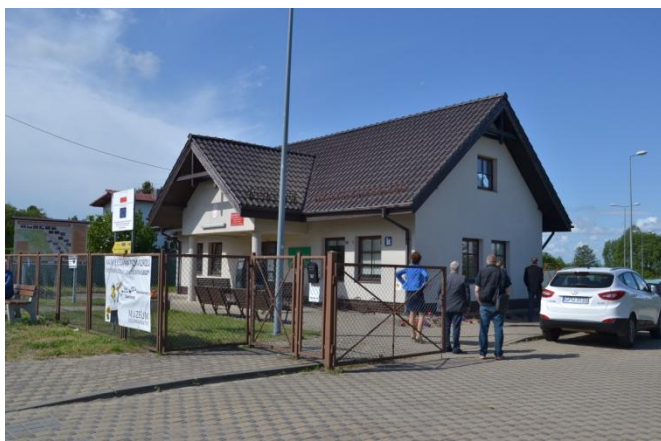
Fot.4 Budynek Informacji Turystycznej z podstawowymi sanitariatami
