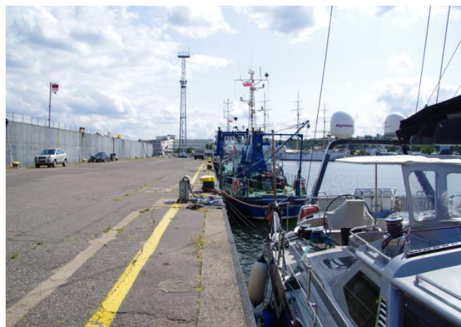
Fot.2 Widok na Pirs Nr 1, strona południowa
