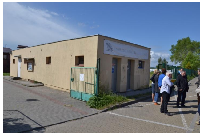
Fot.5 Budynek bosmanatu z sanitariatami
