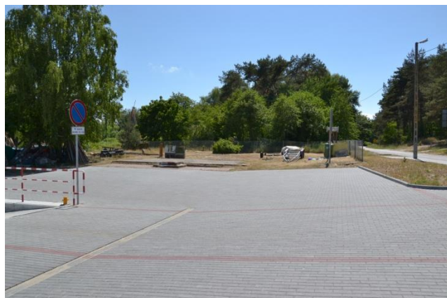
Fot.4 Plac parkingowy. W tle pozostałości budynku odbudowywanego jako bosmanat
