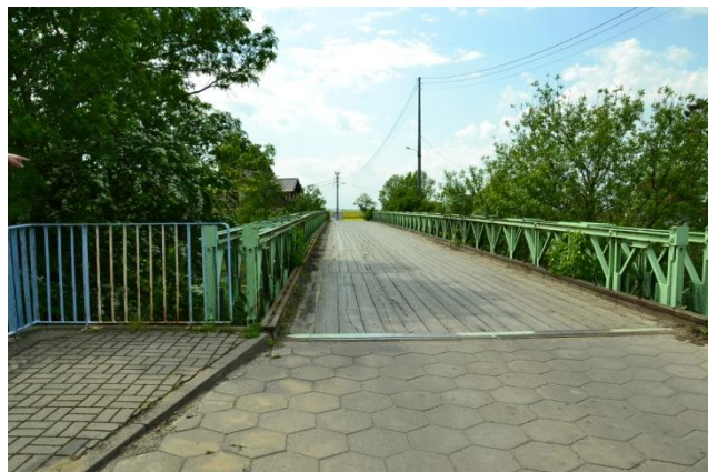
Fot.2 Drewniana nawierzchnia mostu
