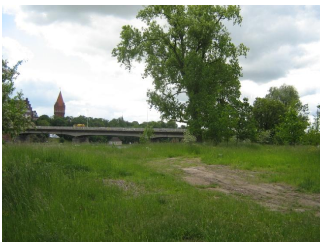
Fot.5 Widok na teren inwestycji, strona Południowa
