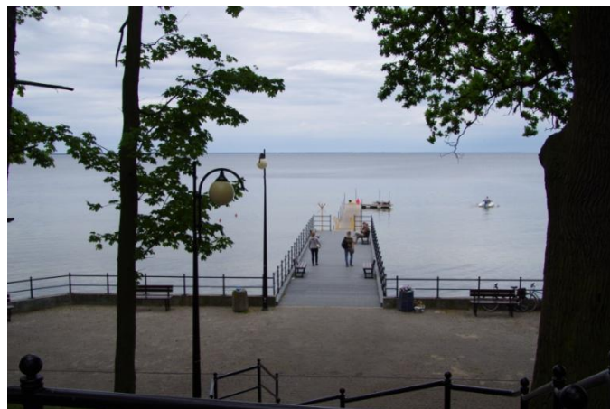
Fot.2 Widok na stały przyczółek, w stronę wschodnią
