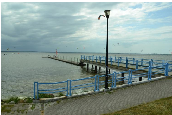
Fot.1 Pomost z przyczółkiem
