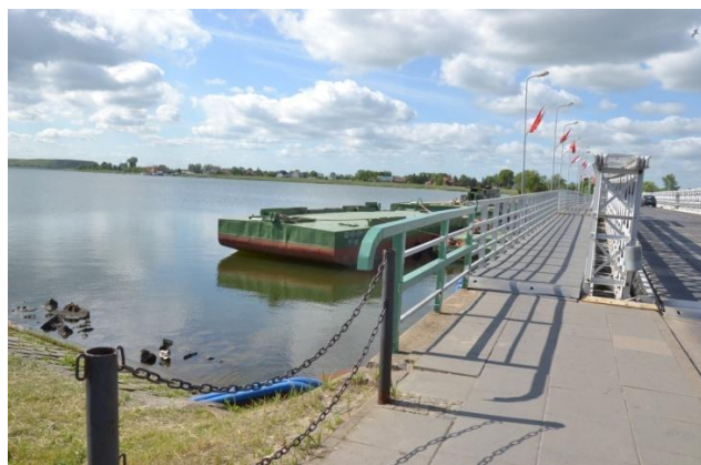
Fot.4 Wydzielona część dla pieszych mostu pontonowego
