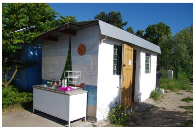
Fot.4 Widok na sanitariaty
