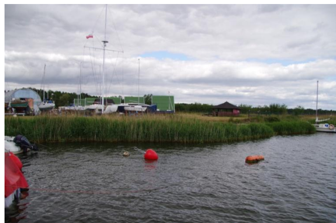
Fot.2 Nabrzeże nieumocnione – lokalizacja projektowanego pomostu pływającego; z tyłu domki kempingowe dla żeglarzy
