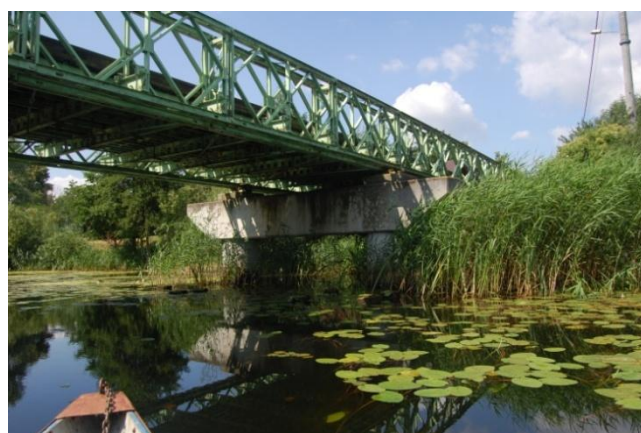
Fot. 5 Widok na posadowienie mostu most w Żelichowie
