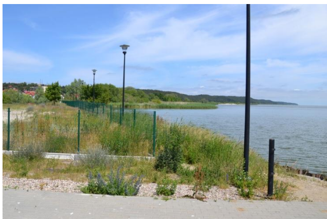
Fot.1 Miejsce realizacji opaski brzegowej
