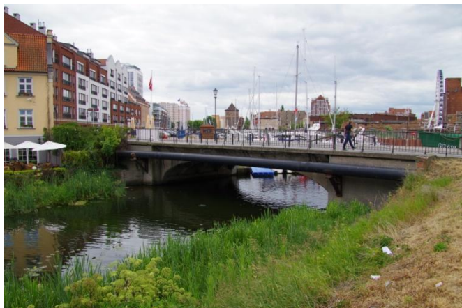
Fot.1 Most stały do planowanej przebudowy
