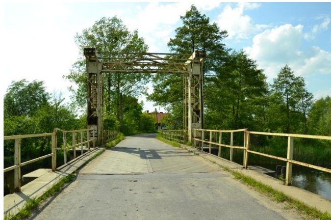
Fot.2 Drewniana nawierzchnia zwodzonej części mostu
