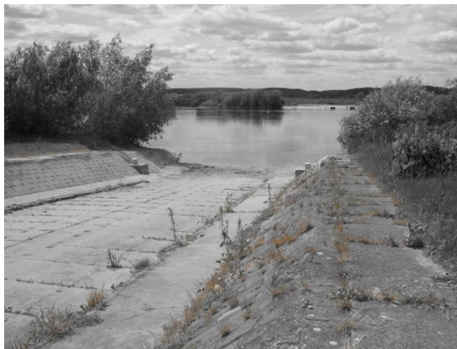
Fot.4 Widok na zjazd dawnego promu
