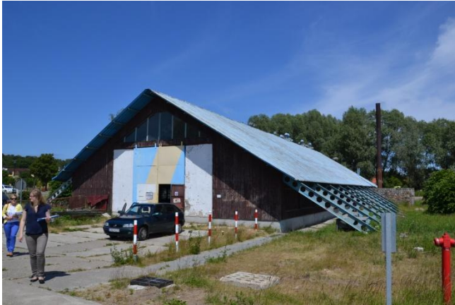
Fot.1 Wejście do hangaru przeznaczonego do rozbiórki
