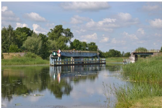
Fot.1 Widok na otwarty most kolejowy z nabrzeża w Rybinie
