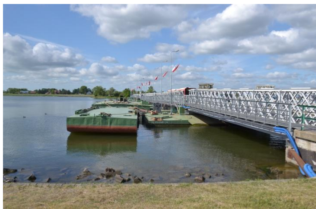
Fot.1 Widok na most pontonowy od strony wschodniej
