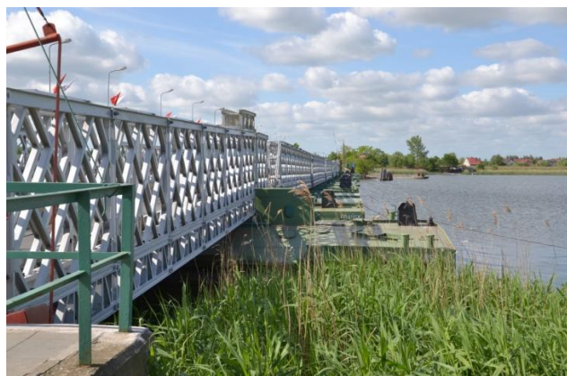
Fot.2 widok na most pontonowy od strony zachodniej
