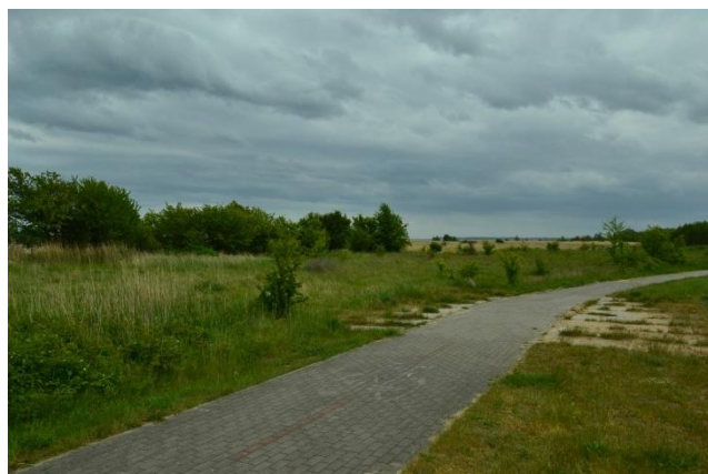
Fot.2 Istniejąca ścieżka rowerowa trasy R-10
