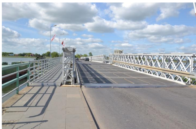
Fot.3 Nawierzchnia mostu pontonowego
