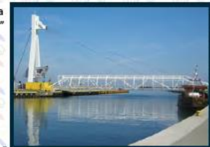
m. Ustka, „Kładka nad Kanalem Portowym”
