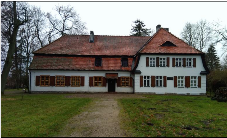
Muzeum Hymnu Narodowego w Będominie – przed termomodernizacją
