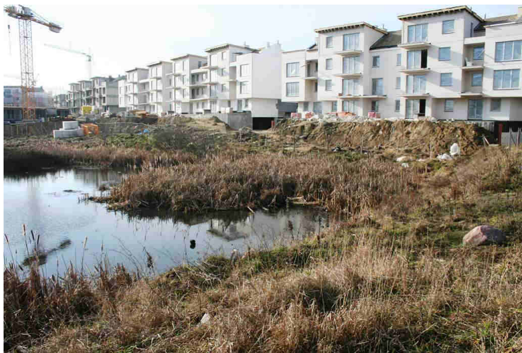
Fot.1.6. Zdegradowana w trakcie budowy i częściowo zabudowana powierzchnia torfowiska przejściowego (w przeszłości wskazywanego do ochrony) z obecnością gatunków chronionych i zagrożonych wyginięciem, w sąsiedztwie użytku ekologicznego "Migowska Bielawa", Gdańsk, okolice ul. Myśliwskiej (fot. J.Czocharński)
