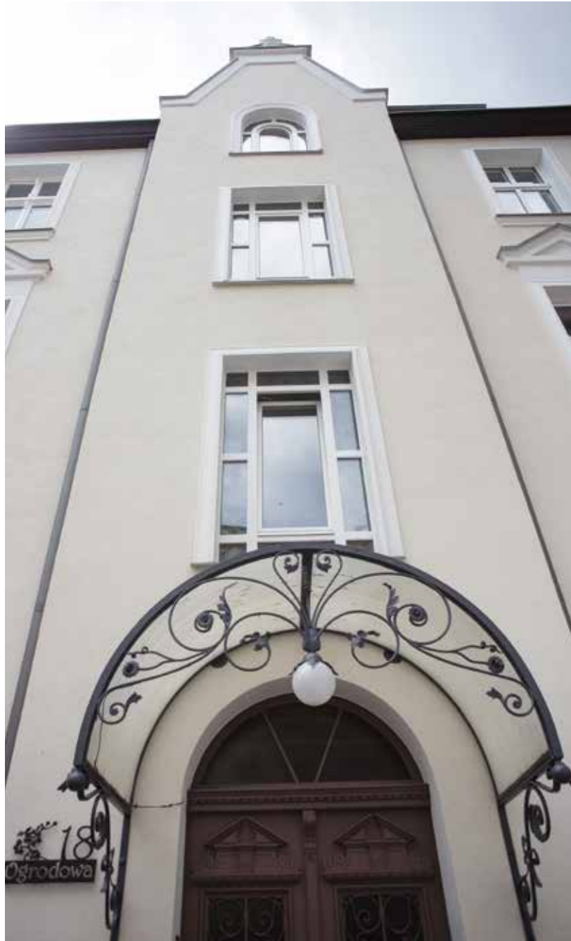
Ul. Ogrodowa w Sopocie. Fot. Maciej Moskwa
