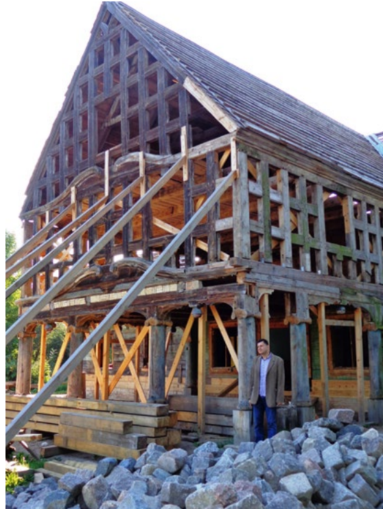
25. Dom w Orłowie w czasie remontu
