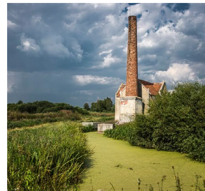
3. Ostatnia pompa parowa w Różanach
