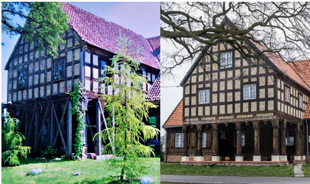
21. Marynowy - dom przed remontem
