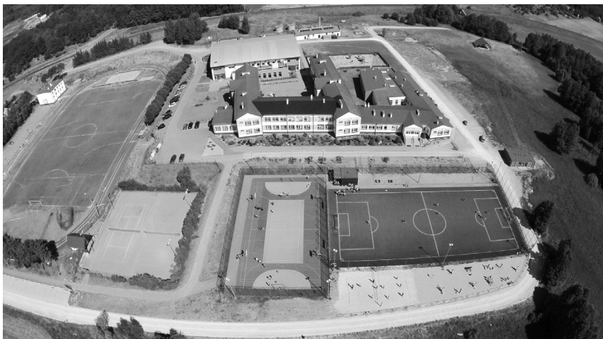
Zdjęcie nr 21. Kompleks sportowo-rekreacyjny w Lipuszu (fot. zasoby ZGP).
