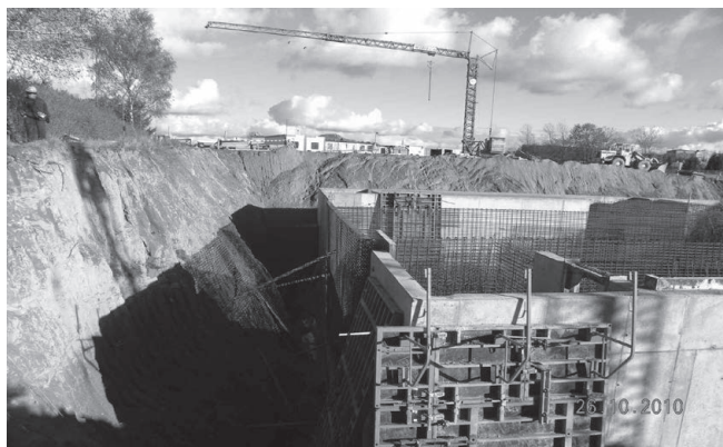
Rozbudowa oczyszczalni ścieków w Sierakowicach. Ochrona środowiska realizowana przez WFOŚ (fot. zasoby WFOŚ)
