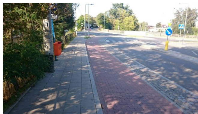
Ilustracja 20, Przeprowadzenie pasa rowerowego w rejonie zatoki autobusowej, opracowanie własne
