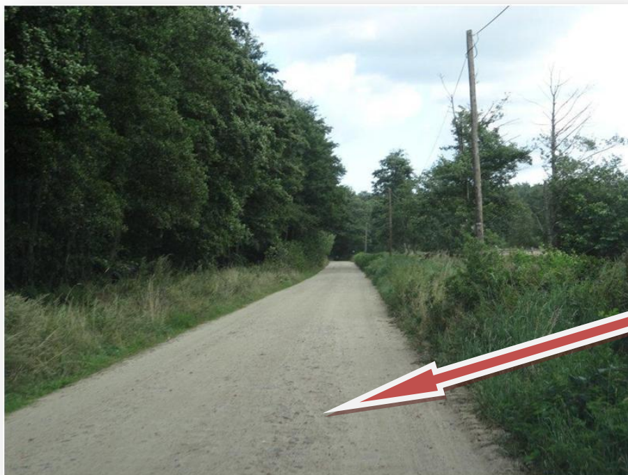
Fotografia 6: Wzorcowa nawierzchnia z kruszywa betonowego (Krokowa)
