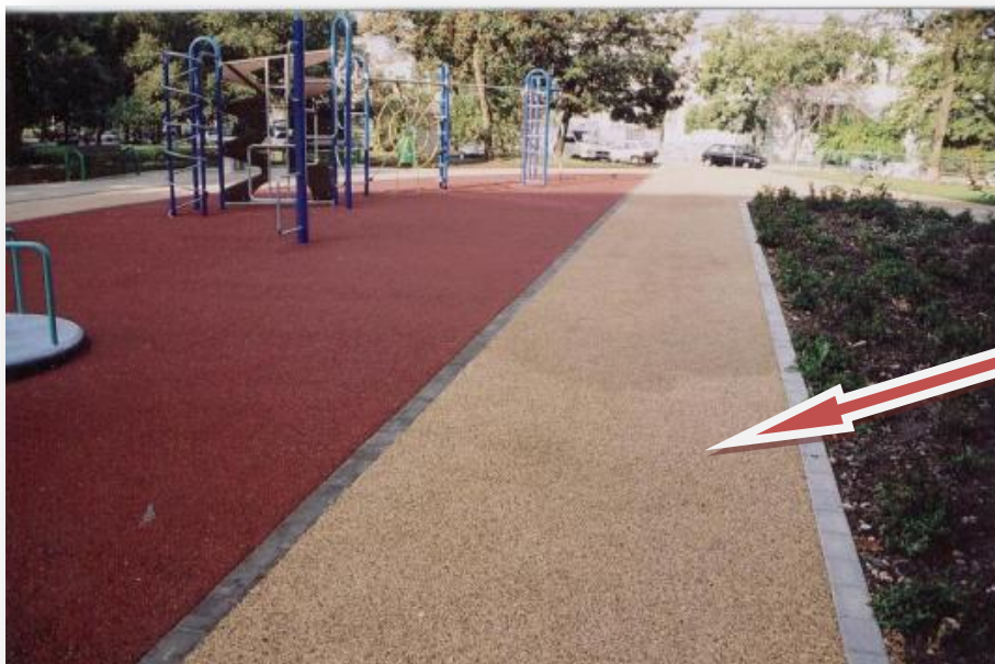
Fotografia 3: Wzorcowa nawierzchnia mineralno-żywiczna (Wrocław)
