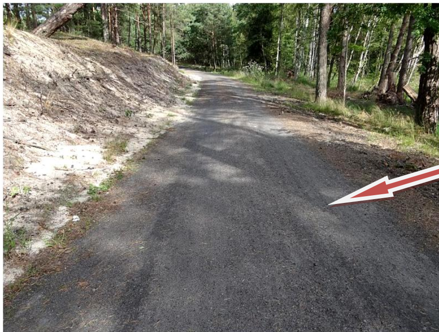
Fotografia 5: Wzorcowa nawierzchnia żuźlowa (Choczewo)
