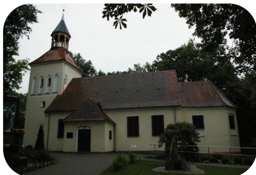
Remont dachu wieży kościół p.w. Najświętszego Serca Pana Jezusa w Kobylnicy
