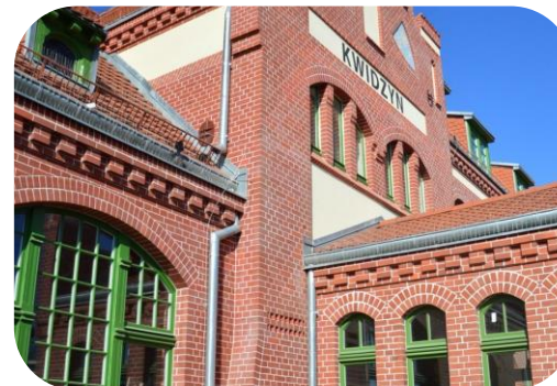
Budowa węzła integracyjnego i rewitalizacja dworca PKP w Kwidzynie
