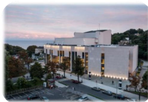
Rozbudowa Teatru Muzycznego im. Danuty Baduszkowej
