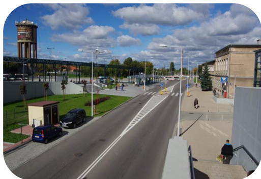
Węzeł integracyjny w Tczewie
